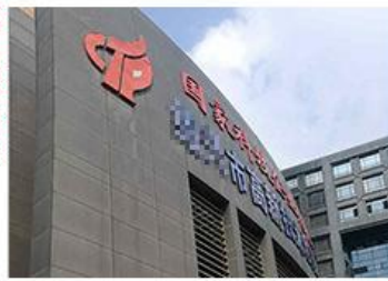
铝塑板外墙翻新
